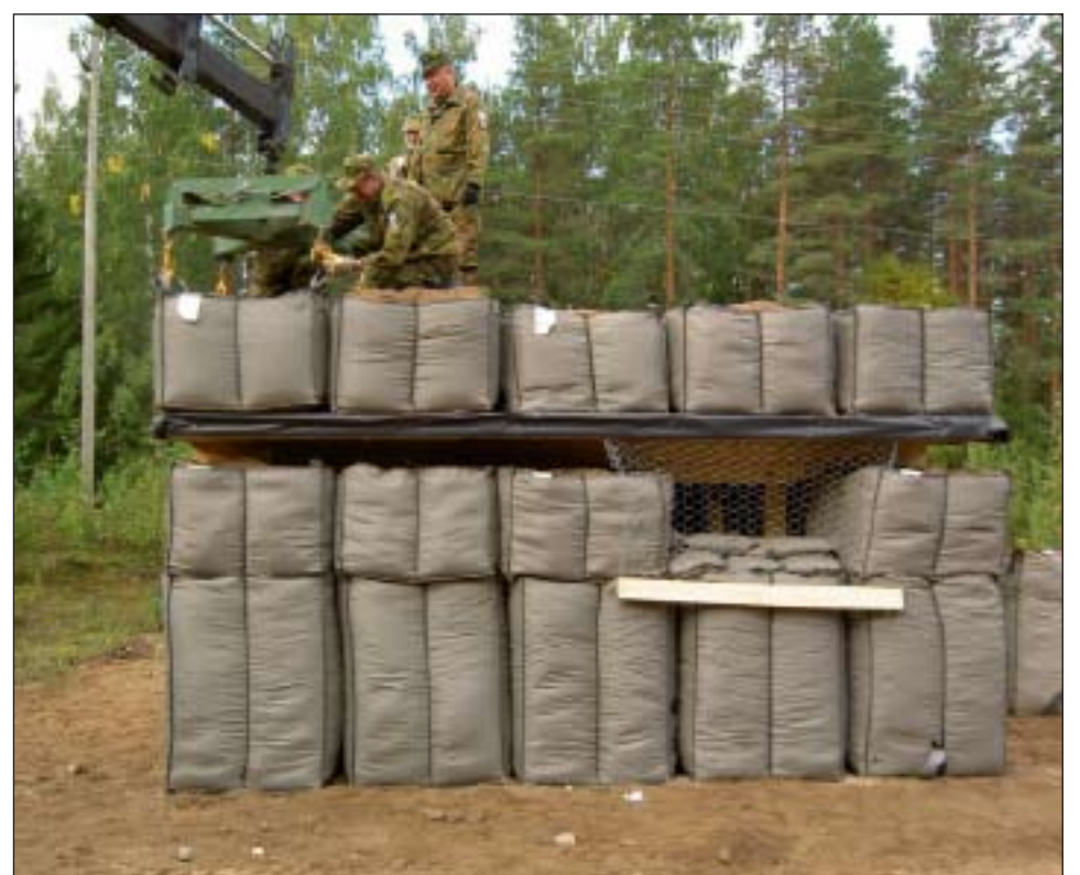
Kuva 1 Suursäkkien täyttölaitte, kuva 2 Kattoparrujen asennus, kuva 3 Viimeinen säkki paikoillaan
